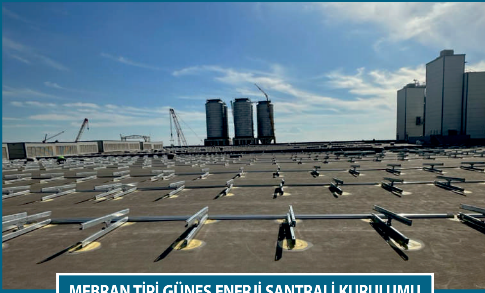
MEBRAN TİPİ GÜNEŞ ENERJİ SANTRALİ KURULUMU
