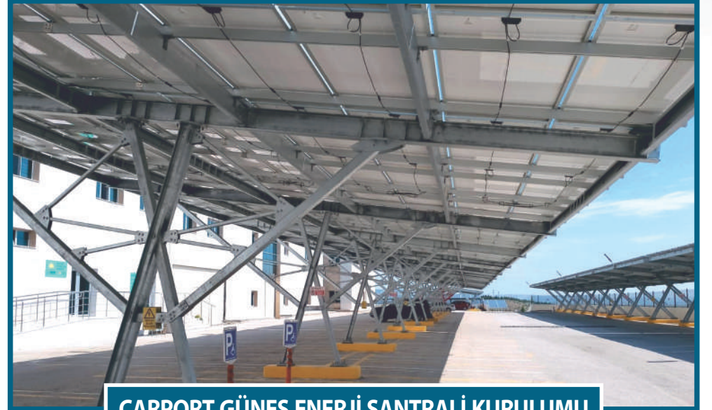
CARPORT GÜNEŞ ENERJİ SANTRALİ KURULUMU
