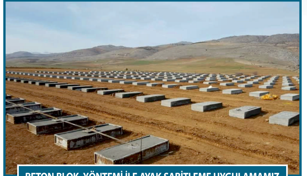
BETON BLOK YÖNTEMİ İLE AYAK SABİTLEME UYGULAMAMIZ
