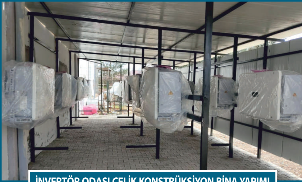
İNVERTÖR ODASI ÇELİK KONSTRÜKSİYON BİNA YAPIMI
